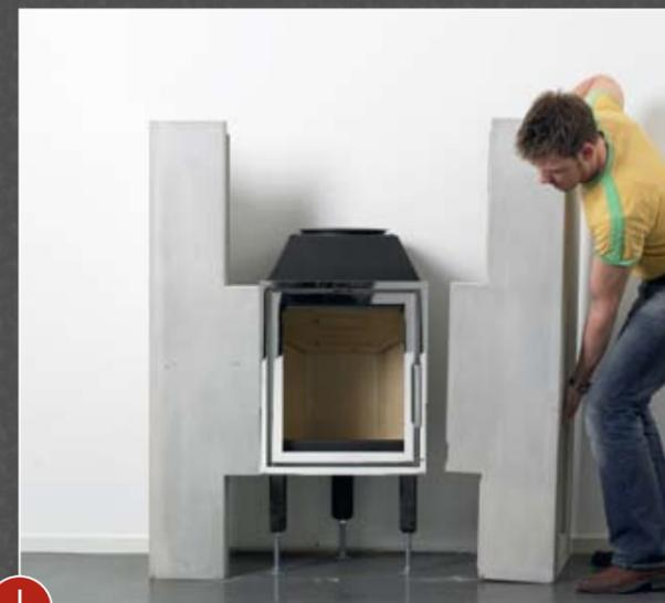
1 Wenn der Kamin auf einem nicht feuerfesten Bodenbelag aufgestellt wird, muss eine hitzebeständige Bodenplatte vor dem Gerät liegen. Diese muss die Feuerraumtüröffnung vorne um mindestens 50 cm und seitlich um mindestens 30 cm überragen.
