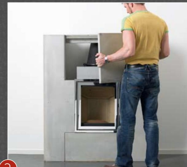
2 Halten Sie sich genau an die Montageanleitung und befolgen Sie den Aufbau Schritt für Schritt. Kontrollieren Sie während der Montage, dass der Kamin waagrecht aufgestellt wird. Die Fertigelemente werden mit Akryl oder Zementkleber miteinander verklebt. Verwenden Sie grosszügige Mengen Kleber.
