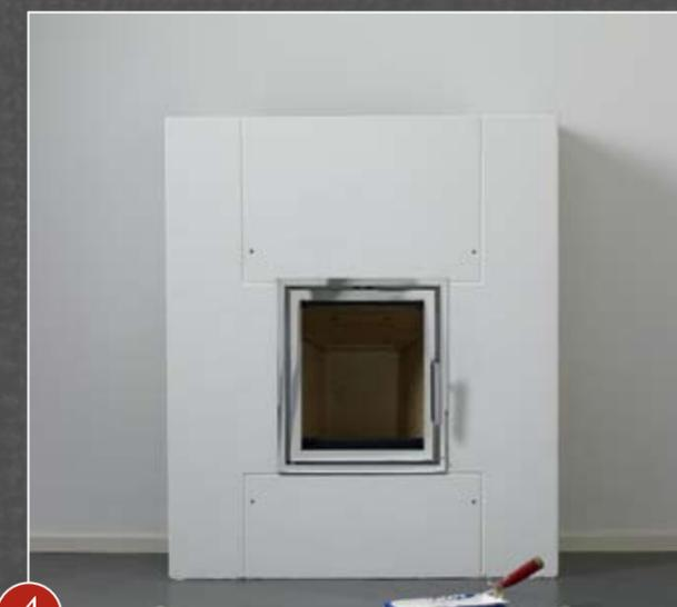
4 Der Anstrich der Kaminverkleidung kann gleich nach Trocknen des Klebers erfolgen. Verwenden Sie Akrylfarbe oder eine andere Farbe auf Wasserbasis. Wenn der Anstrich trocken ist, setzen Sie die Luftgitter ein. Dann brauchen Sie nur mehr die Bodenplatte hinzulegen, fertig! Hier haben wir die Kaminverkleidung in weiss gestrichen und für die Montage einer Glasfront vorbereitet.
