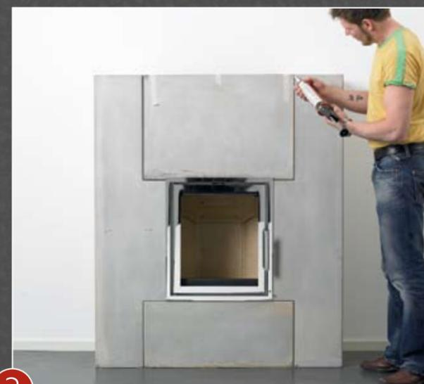
3 Unebenheiten beim Übergang zum Boden können mit dem mitgelieferten Zementkleber ausgebessert werden. Zum Schluss können Sie alle Zwischenräume mit hitzebeständigem, übermalbarem Spezialacryl verspachteln. Die Übergänge zwischen Kamin und Brandschutzmauer müssen verfugt werden. Überflüssige Fugenmasse entfernen Sie. Fahren Sie mit dem Finger drüber, sodass eine Vertiefung entsteht. Zum Glätten streichen Sie vorsichtig mit einem feuchten Schwamm über die Fugen.
